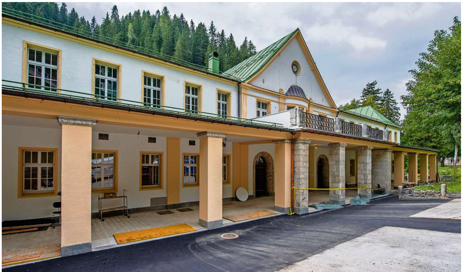
Von aussen fast unverändert: Das Gebäude aus dem Jahr 1913 wurde sanft renoviert und wo nötig im Sinne der Erbauer weiterentwickelt. (FOTO ROLF CANAL)
